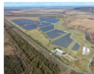
釧路町トリトウシ原野 太陽光発電所全景
