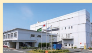
GSユアサ エナジー-外観
