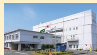
GSユアサ エナジー-外観
