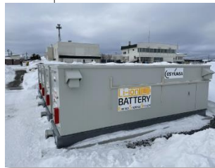
風力発電蓄電システムコンテナ外観
