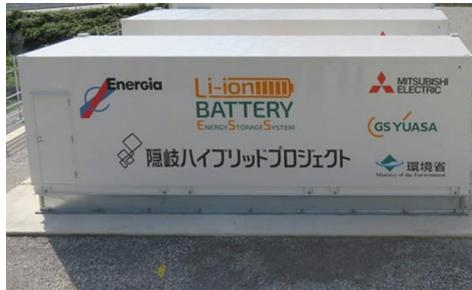
島根県隠岐郡 西ノ島変電所のリチウムイオン電池システム
