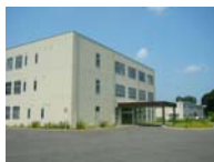
リチウムエナジージャパン 新工場
