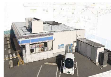
PV-EVシステム
