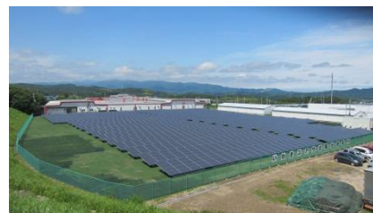
【第一弾】いわきユアサ(いわき市) 2013年6月稼働
