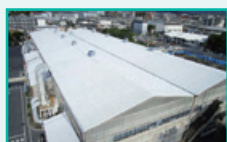
遮熱塗装後の工場の屋根
