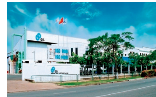
ジーエス バッテリー ベトナム社の外観写真
