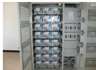
「エコステ」モデル駅のJR東北本線 平泉駅に240kWhのリチウムイオン電池蓄電システムを導入
