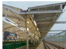
太陽光発電システム 透過性パネルを設置
